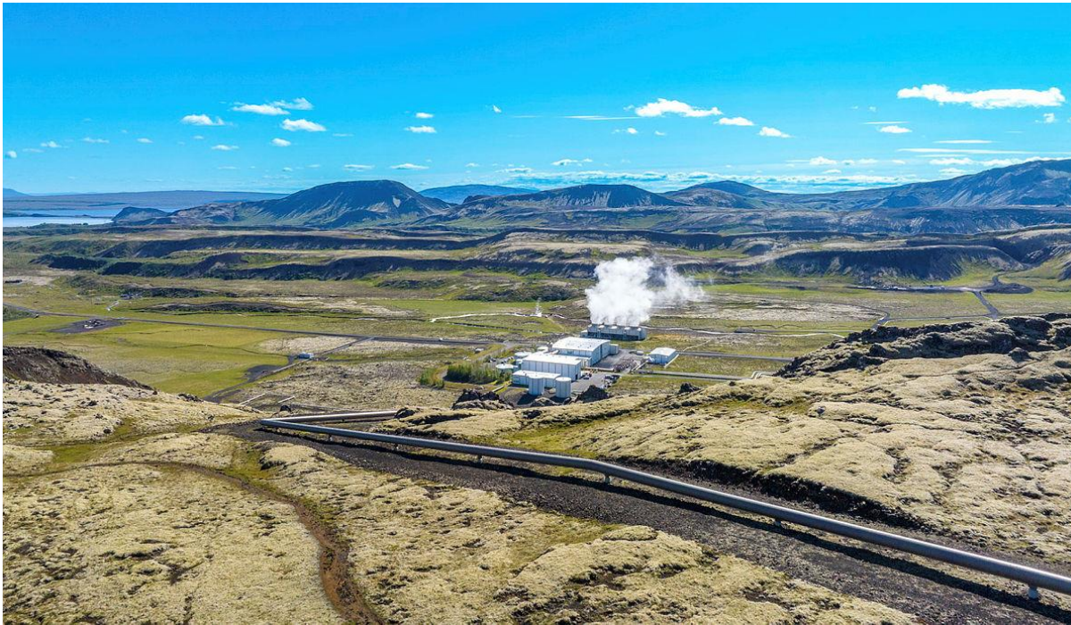
Mynd 5.4 Horft yfir Nesjavallasvæðið í suðurátt. Stöðvarhús virkjunarinnar er fyrir miðju. Ljósmynd Einar Jónsson, Orkuveitan.
