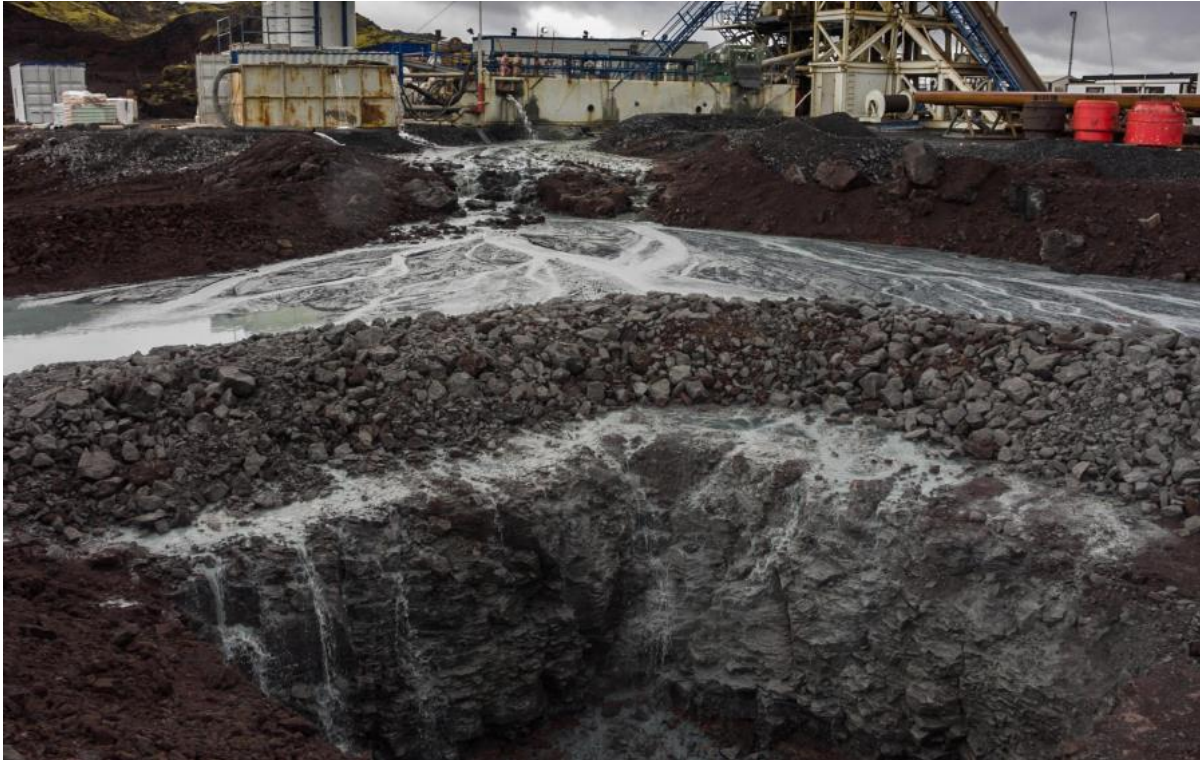
Mynd 4.3 Yfirlit yfir frárennsli svarfs á borplani. Neðst á myndinni er svarfþróin sem svarfið rennur í. Frárennsli kemur frá bornum og dælukari. Mynd: Grétar Ívarsson (Verkís, 2020).
