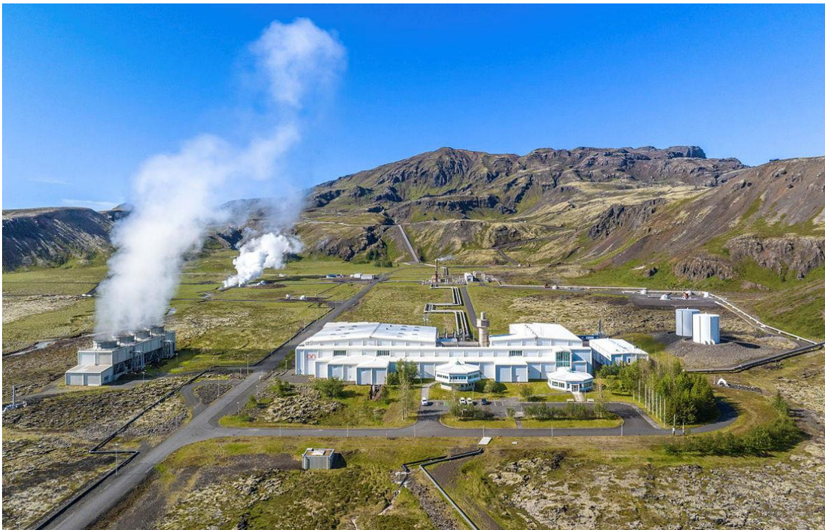
Mynd 5.3 Horft yfir Nesjavallasvæðið í suðvestur. Hengill í bakgrunni og stöðvarhús virkjunarinnar í forgrunni. Ljósmynd Einar Jónsson, Orkuveitan.
